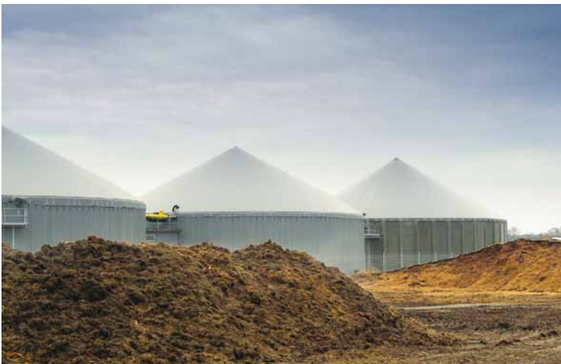
Planta de Biogás.
